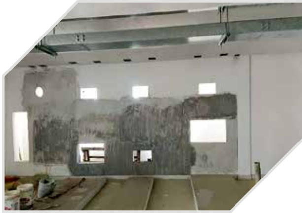
Imagen 1: Estado de las instalaciones del CCRP 2020
