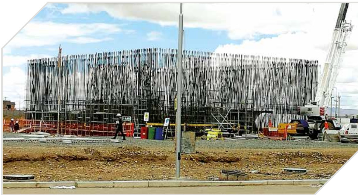
Imagen 3: Avance de las obras de construcción del Reactor Nuclear de Investigación.
