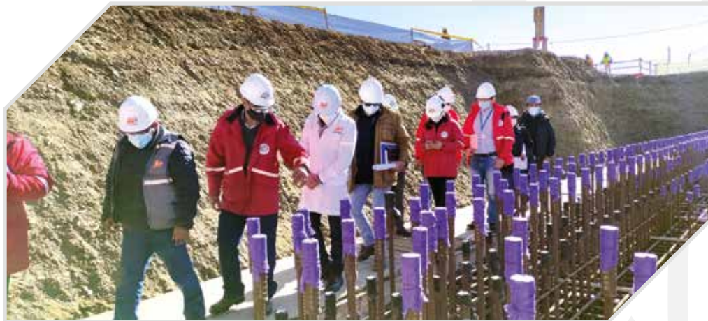
Imagen 1: Inspección de la AETN para la autorización del vaciado de la primera loza del reactor de investigación.
